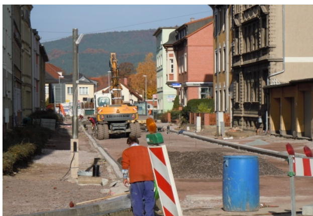
Kulmstraße, Gas und Strom, Erneuerung Gashauptleitung, NA Gas, Austausch MS-Kabel-System und NS-Kabel, teilweise NA Strom neu, Neuverlegung Leerrohr und Mikroröhrchen
