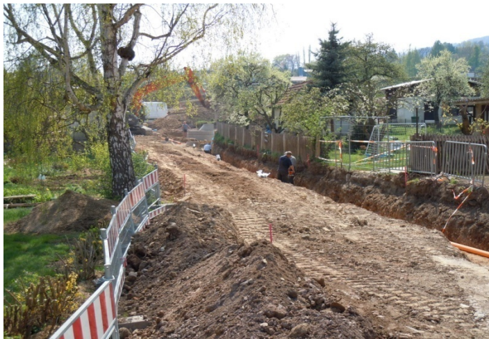
Wohngebiet westlich der Pirmasenser Straße, Gas und Strom, Neuverlegung Gashauptleitung, NA Gas; Neuverlegung NS-Kabel, NA Strom, Mikroröhrchen
