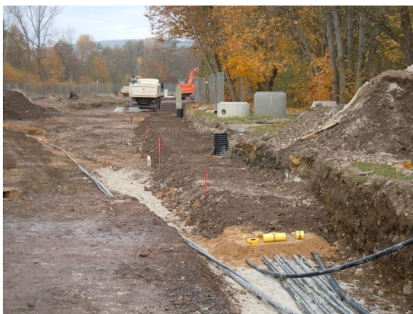
Carl-Zeiss-Straße, Strom, Umverlegung MS-Kabel-Systeme, NS- und FM-Kabel, Leerrohr
